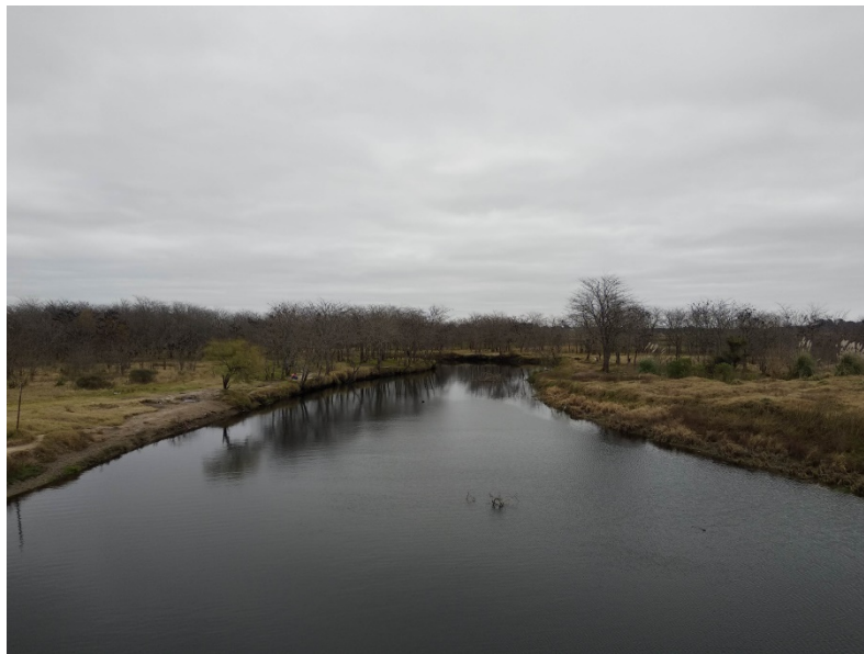
PRL8 en Puente en RN9, fecha: 10/2021
