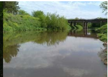
PRL5 en Puente sobre RP6, fecha: 10/2019
