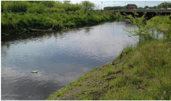
PRL6 en Puente en RN8, fecha: 01/2020
